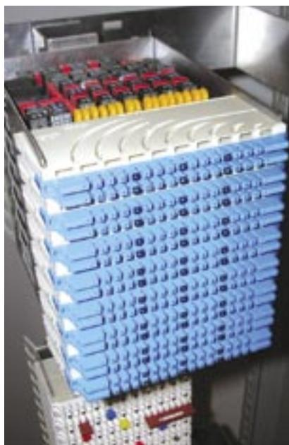
**Рис. 14.** Кросс Corning, предназначенный для подключения ADSL-сплиттеров
