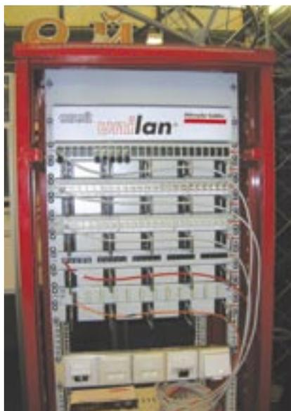
**Рис. 15.** Вот так выглядят элементы кабельной системы для передачи информации со скоростью 10 Гбит/с на стенде компании «Эней»
